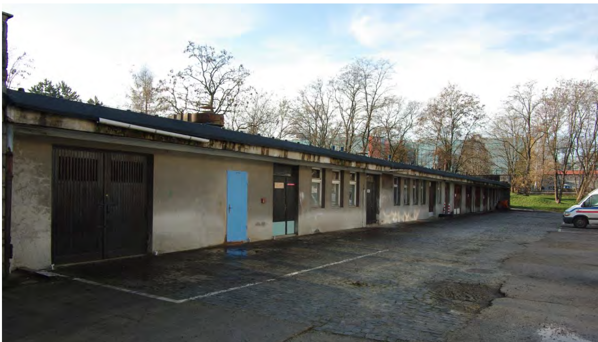
Rycina 6: Stan obecny – Budynek pomocniczy
