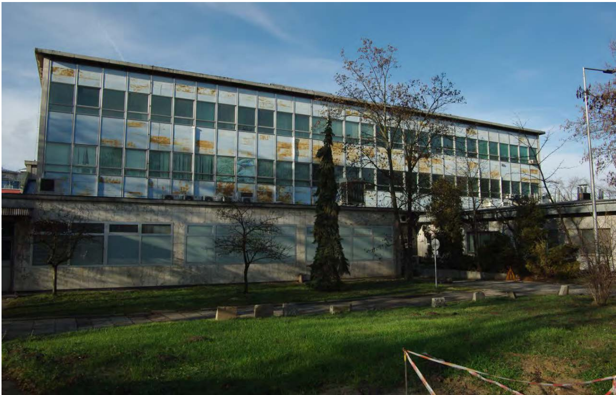
Rycina 7: Stan obecny – Budynek CLS
