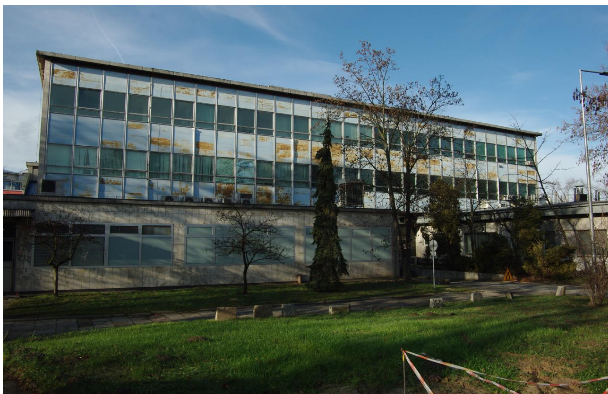
Rycina 7: Stan obecny – Budynek CLS
