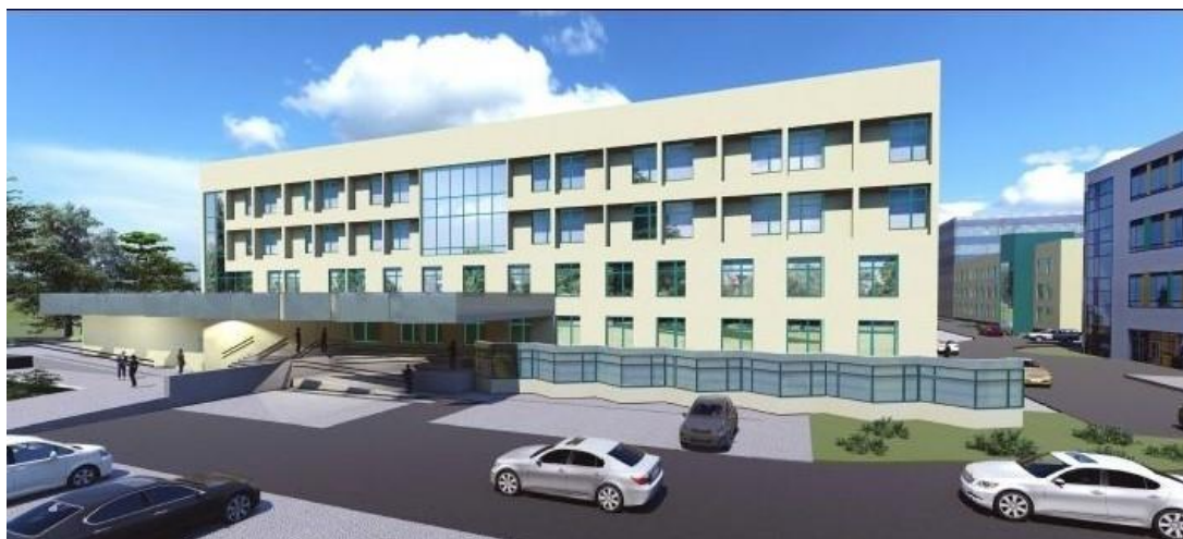
Widok od Parku Skowroniego – wejście główne
