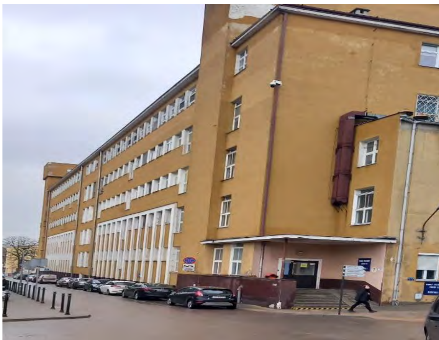
Zdjęcie nr 2 – Budynek nr 8 przeznaczony do rozbiórki.
