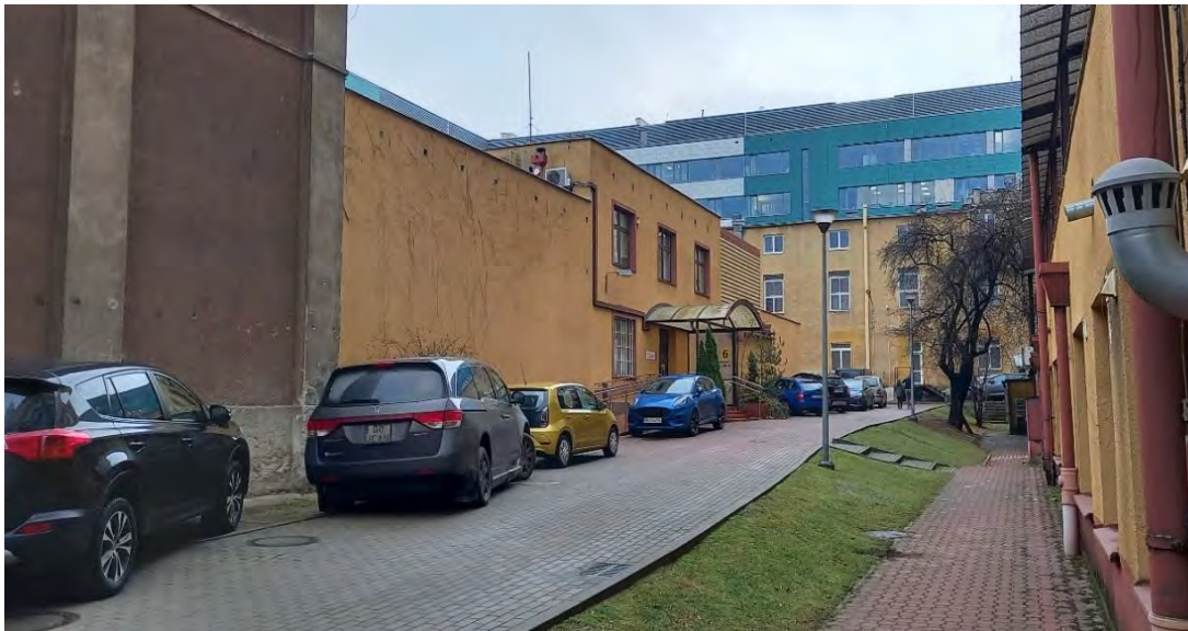
Zdjęcie nr 4 – Budynek nr 6 przeznaczony do rozbiórki.
