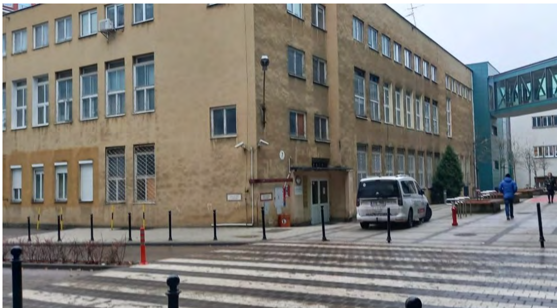
Zdjęcie nr 1 – Budynek nr 7 przeznaczony do rozbiórki.
