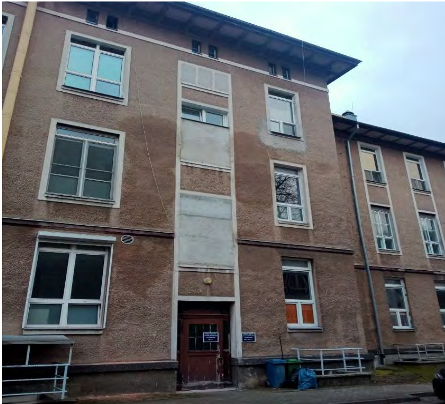
Zdjęcie nr 5 - Budynek nr 4 elewacja zachodnia.
