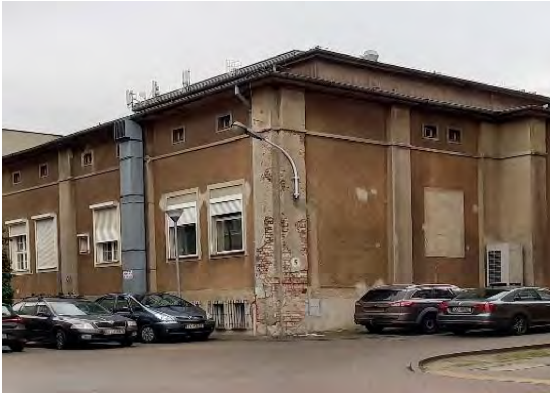
Zdjęcie nr 3 – Budynek 5A przeznaczony do rozbiórki.
