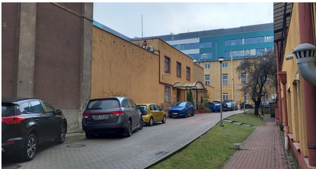
Zdjęcie nr 4 – Budynek nr 6 przeznaczony do rozbiórki.
